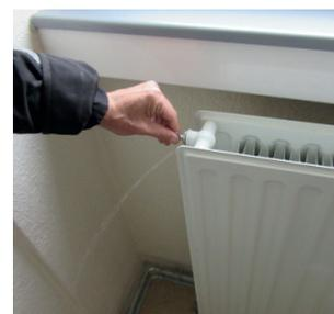
**Etape 3 :** une fois tous les radiateurs purgés, vérifier que l'aiguille du manomètre se situe entre 1 et 2 bars. Si non, ouvrir les vannes de remplissage jusqu'à ce que l'aiguille se situe entre 1 et 2 bars puis fermer les vannes.
