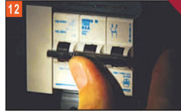
**12** réarmez si nécessaire le disjoncteur, vous disposerez d'un crédit de secours limité, sans limitation de puissance.
