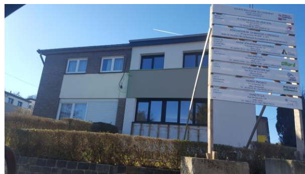
Avenue Joseph Merlot (avant et pendant travaux)
