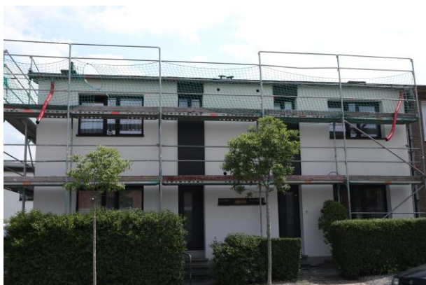
Rue Ernest Malvoz (pendant travaux)
