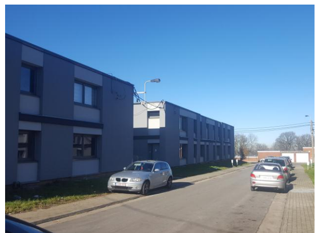
Rue Floréal (après chantier)
