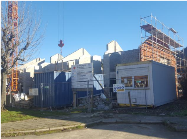
Rue des Partisans (chantier en cours)
