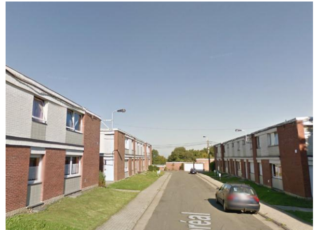
Rue Floréal (avant chantier)
